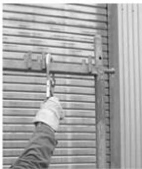
Použití OOPP na lešeních standardního provedení, která však nejsou ukotvená, není povoleno, neboť hrozí nebezpečí, že by se lešení při pádu osoby mohlo převrátit. OOPP má smysl použít až od 3. podlaží lešení od 5 m výšky, neboť padající osoba by vzhledem k délce lana OOPP a své tělesné výšce dopadla na zem dříve, než by OOPP začal účinně fungovat.
